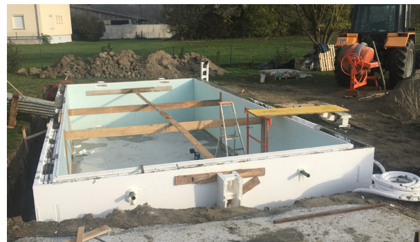
Versteifung der Poolwände vor der Befüllung
