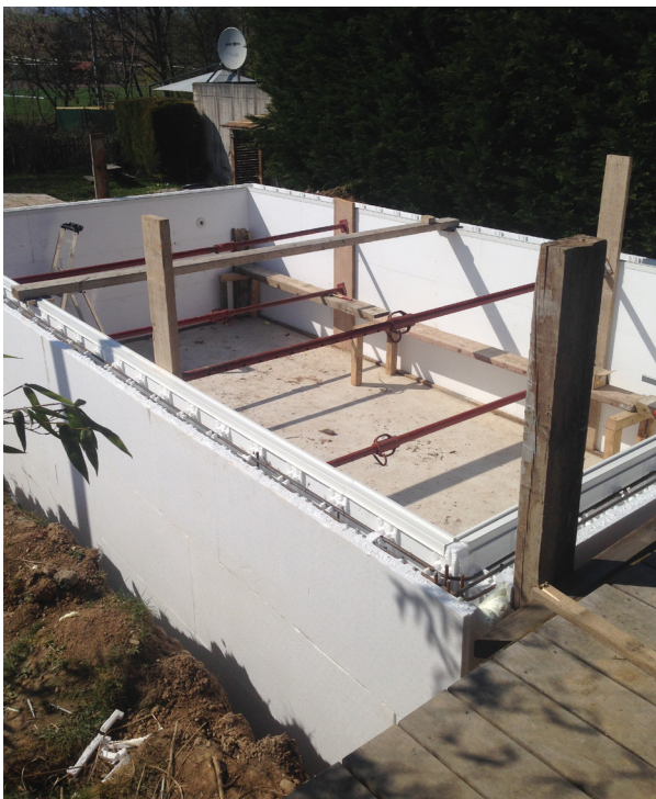
Versteifung der Poolwände vor der Befüllung
