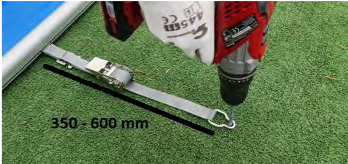
9. Wir verspannen die Abdeckung mit der Spannkammer.
